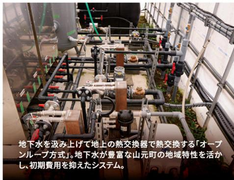
地下水を汲み上げて地上の熱交換器で熱交換する「オープンループ方式」。地下水が豊富な山元町の地域特性を活かし、初期費用を抑えたシステム。
