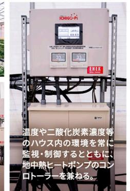
温度や二酸化炭素濃度等のハウスの環境を常に監視・制御するとともに、地中熱ヒートポンプのコントローラーを兼ねる。
