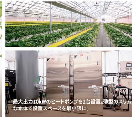
最大出力10kWのヒートポンプを2台設置。薄型のスリムな本体で設置スペースを最小限に。
